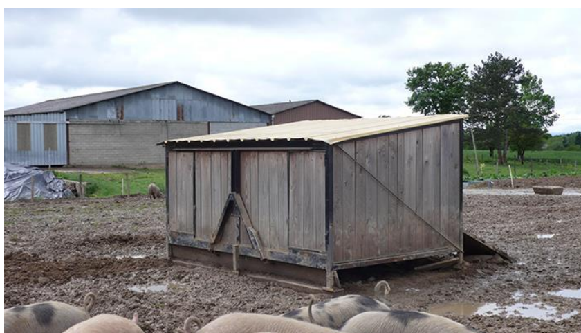
Photo 39. Cabane mobile coconstruite dans le cadre d'une formation organisée par l'association Atelier paysan. Grâce à sa structure métallique, il serait possible d'imaginer un ajout latéral (précaution à voir de nouveau pour le toit en tôle et le risque de surchauffe).
