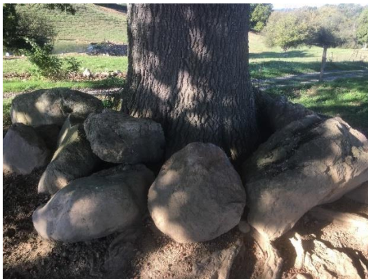
Photo 24. Protection par empierrement.
